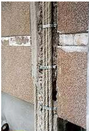
Verankerung der ausbeulenden Bewehrungsstäbe
