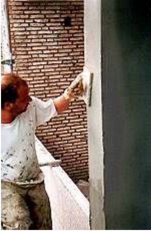
Glätten der Betonoberfläche
