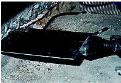
Einschlagen der HW-Chromstahlsperre
