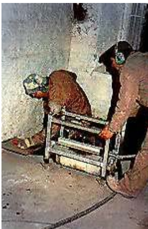
Einschlagen der Platten
