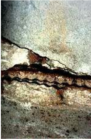
Überlappung der eingeschlagenen Platten
