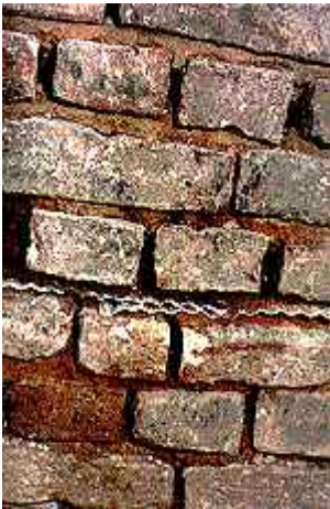
Eingebaute Sperrlage im Mauerwerk
