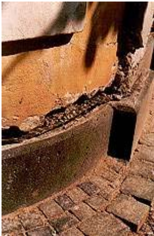
Detail der eingeschlagenen Platten in der Rundung
