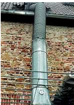
Erhitzte Luft wird in den Dachraum geblasen
