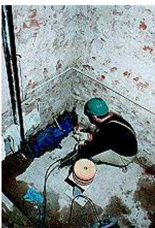
Verpressen eines gemauerten Aufzugsschachtes
