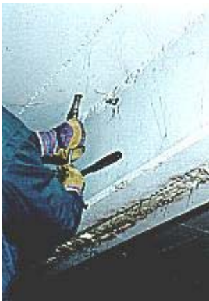
Einsetzen eines Injektionsventils
