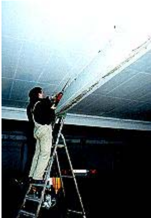
Bohren eines Injektionskanals
