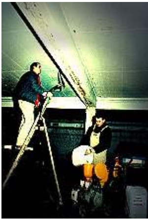
Injizieren des Polyacrylatgels in die verdämmte Fuge
