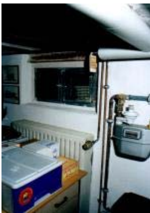
Kellerräume nach Aufbringen des Sanierputzes
