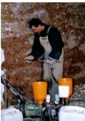
Einpressen von Injektionsharz in die Betonwand
