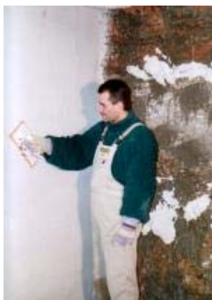
Abreiben des Sanierputzes
