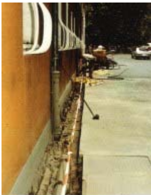
Reparatur des Regenkanals
