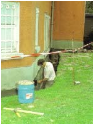
Bituminöse Außenabdichtung
