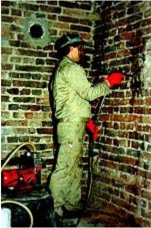
Verpressen mit pilztötenden Wirkstoffen
