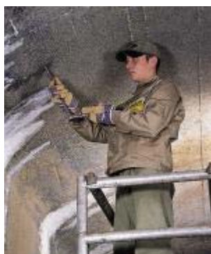
Setzen von Hochdruckrückschlagventilen (Packer)
