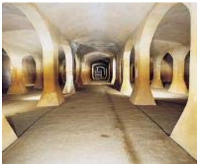
Tonnengewölbe des Beton-Reinwasserbehälters
