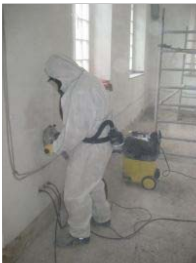
Entfernen von belasteten Oberflächen
